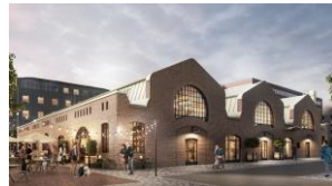
Hus 48 Lilla Marknadshallen OFFICES
